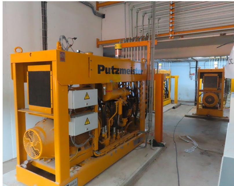
Hydraulikaggregat HA 55 E der dritten Linie, die anderen beiden sind im Hintergrund sichtbar
