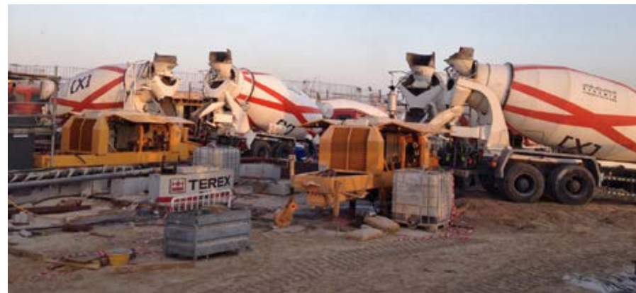
► Insgesamt 65.000 m³ Beton pumpen die beiden BSA 2110 HP D für dieses Projekt
