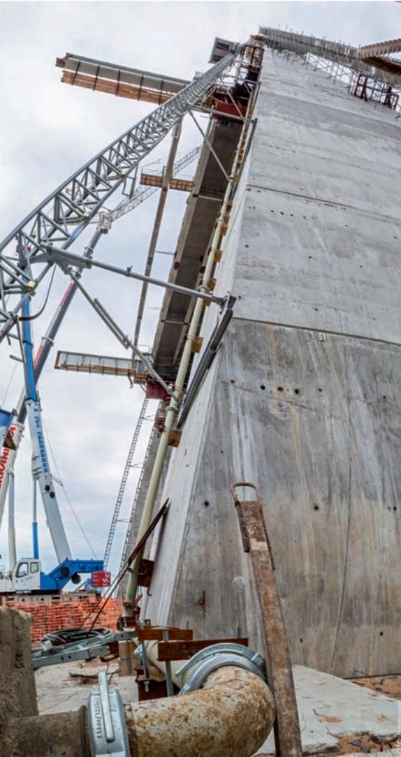
▲ Beton wurde durch SK Förderleitungen bis in eine Höhe von etwa 96 m gepumpt
