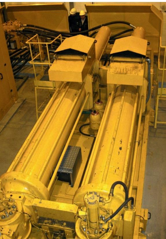
▲ Zwei der insgesamt sechs HSP 25150 HP Pumpen im Kraftwerk Belchatow
