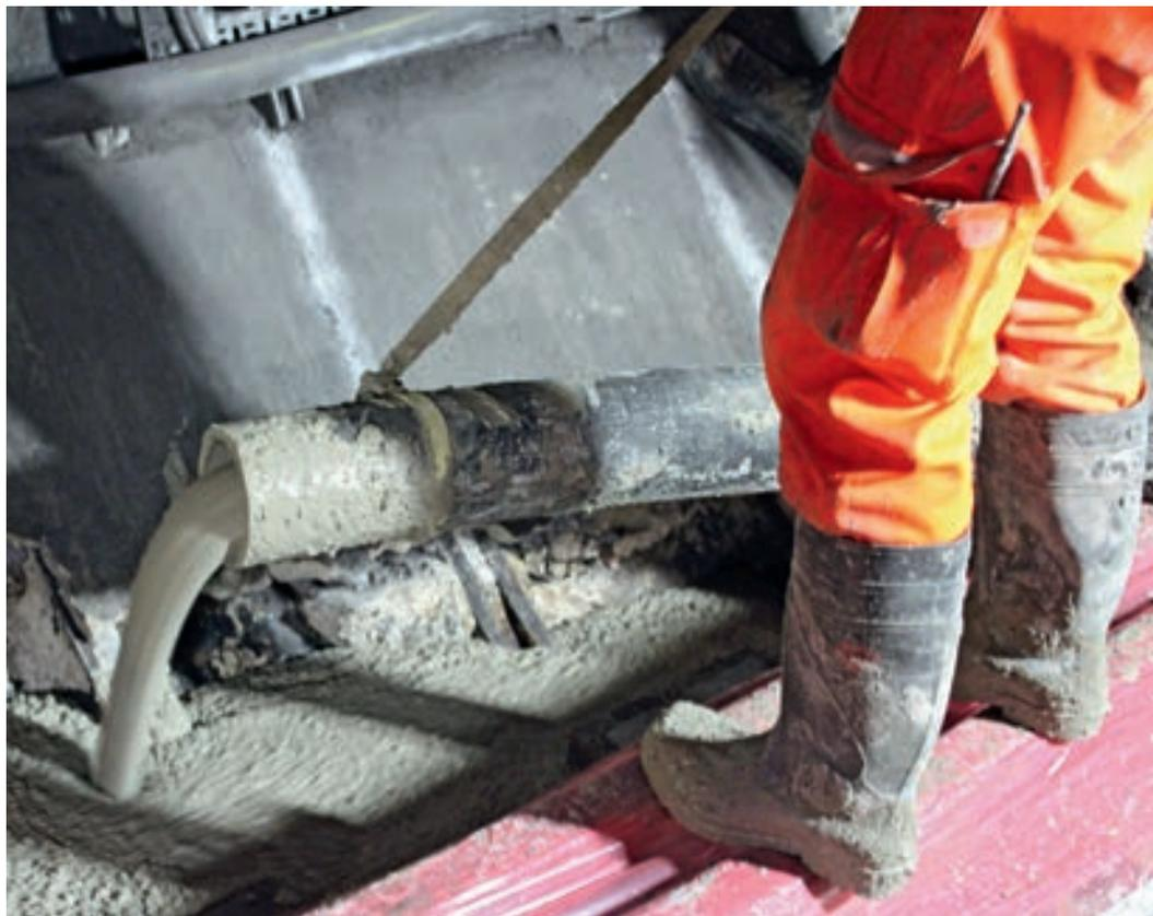
Die Betonagearbeiten wurden in zwei Etappen bewältigt. Zunächst mussten zwei parallele Kammern in der Kaverne unter dem Gleis gefüllt werden: Jede Kammer mit einem Volumen von ca. 105 Kubikmetern wurde über fünf der Länge nach verteilte Öffnungen befüllt. Anschließend musste das Gleisbett betoniert und die Schienenschwellen in die Betonplatten eingebettet werden.
