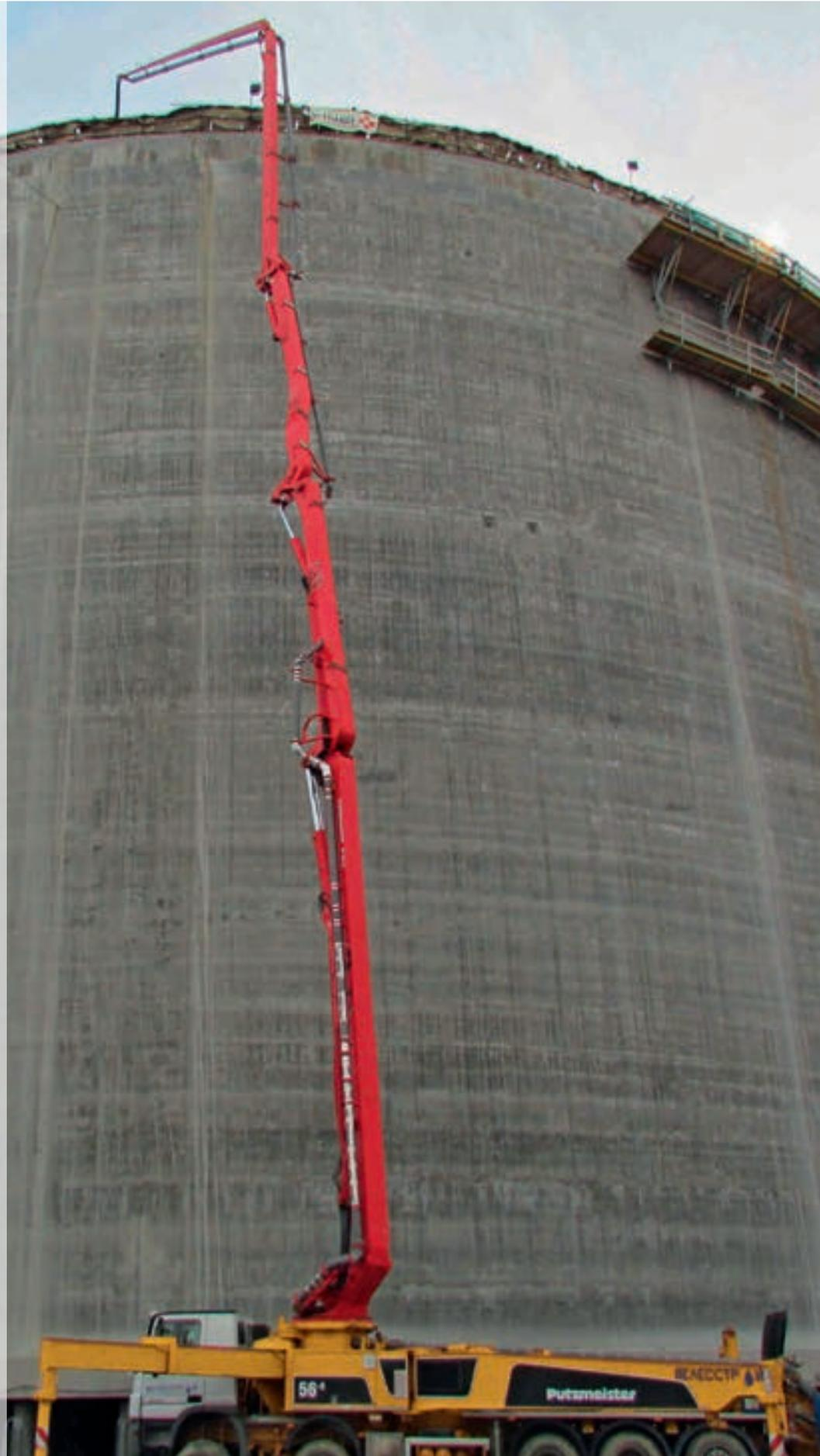
Die Wände der LNG Tanks hatten Stationärpumpen von Putzmeister betoniert. Insgesamt wurden auf der Baustelle sieben Stationärpumpen BSA 1407 D und zwei BSA 2110 HP D sowie sieben Rundverteiler RV 13 eingesetzt. Die Pumpen des Typs BSA 1407 D haben eine Förderleistung bis zu 71 m<sup>3</sup>/h, wobei die Betonmischung (Körnung 25 – 40 mm) bis 100 m in die Höhe bzw. bis zu 200 m horizontal gefördert werden kann.
