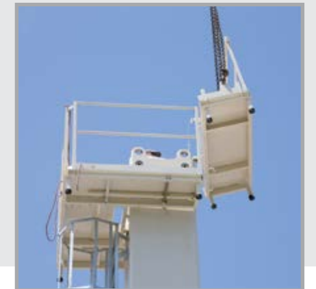
Montaje de la pluma MX con la plataforma de trabajo de seguridad opcional
