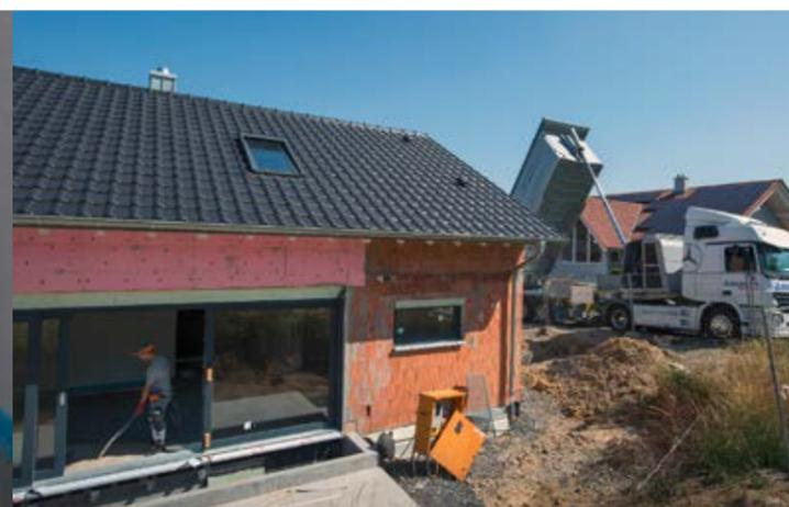
Chantier isolation en vrac avec polystyrène
