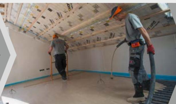
Aplicar betonilha líquida (TransMix 3200) ou betonilha tipo terra húmida (TransMix 5500) – comando através de controlo remoto
