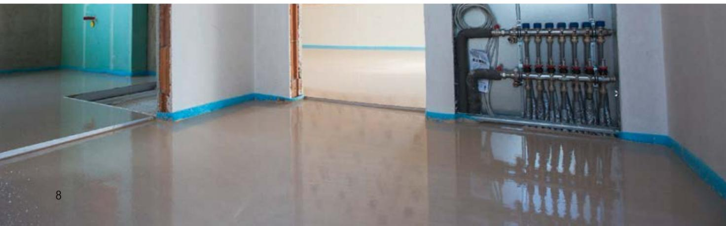
Aplicação de betonilha líquida de sulfato de cálcio com TransMix numa moradia
