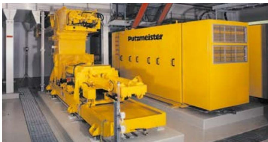
Coincineración de lodos cloacales en la Central termoeléctrica (Carbón) de Zolling (Alemania). Se utilizan bombas KOS 2180
