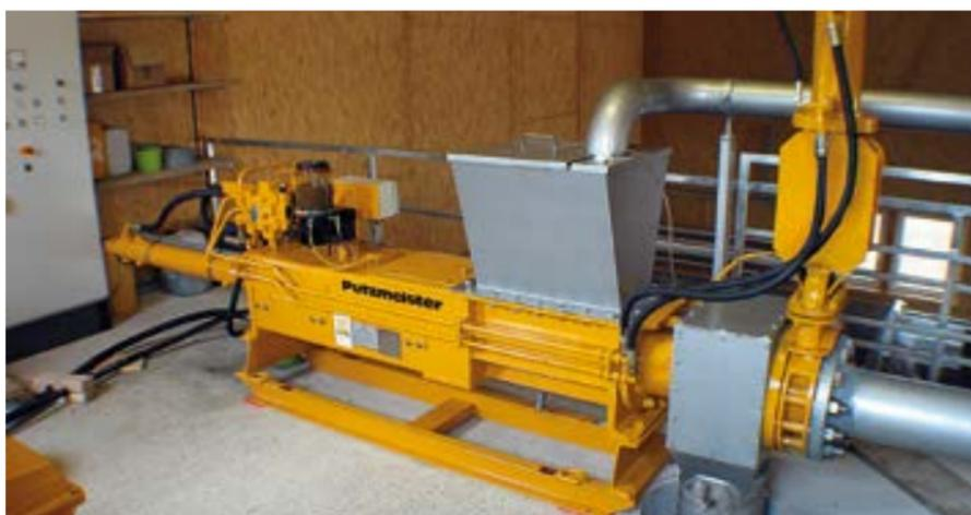
Bomba EKO 1060 PP para el desempaquetado y transporte de alimentos vencidos en la planta de biogás de Kössen (Austria)
