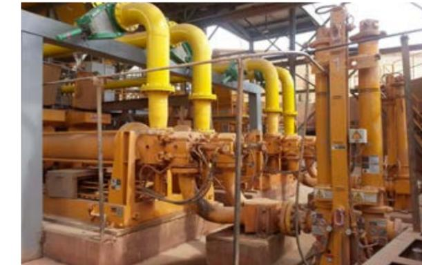
Sistema VPD instalado después de una bomba de pistón HSP para el manejo de relaves
