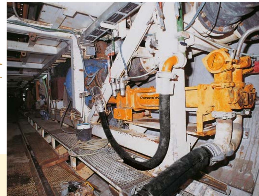
Eine KOV 1050 pumpt Injektionsmörtel hinter die Tübbinge
