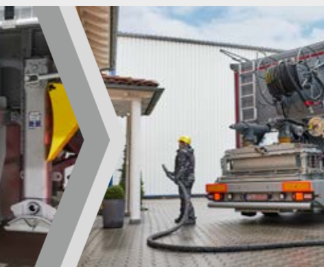
Mise en place du chantier
