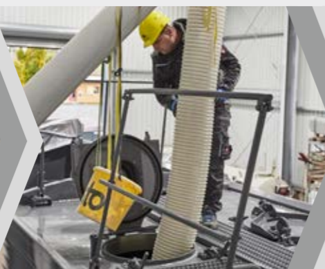
Remplissage de la chambre à liant
