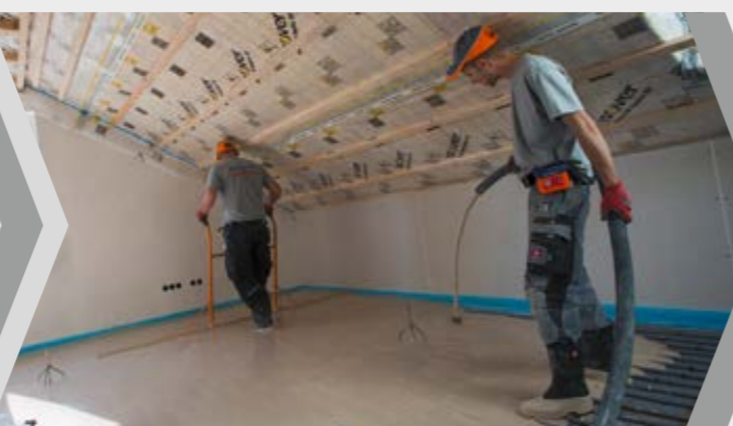
Coulage de la chape liquide
