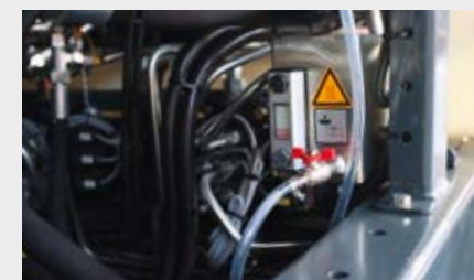
Bomba de agua de alta presión con protección contra el funcionamiento en seco
