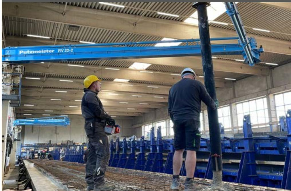
Bétonnage des plafonds Pi avec distributeur rond RV22-2
