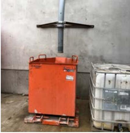
Conduite de nettoyage pour le reste du béton et l'eau du nettoyage à l'extérieur de l'atelier
