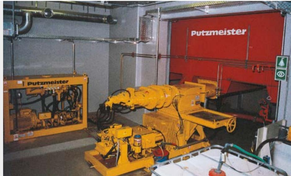
**Oben:** 60 m<sup>3</sup> Annahmesilo mit Injektionspumpe KOS 540 und Hydraulikaggregat HA 45 im Müllheiz-kraftwerk Vestkraft, Dänemark
