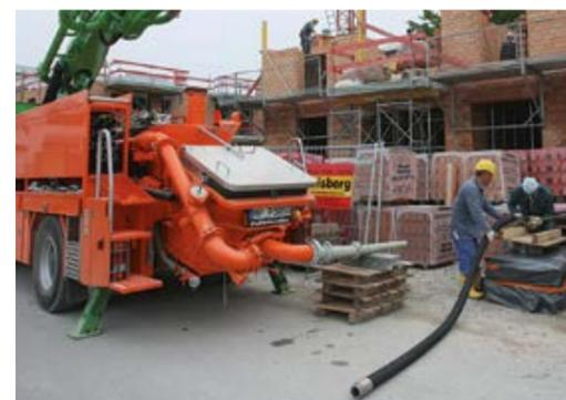
Die 20-4 Sanima als reine Schlauchpumpe: An den um 180 ° gedrehten Klappbogen können Reduzierungen für DN 65 Förderschläuche angeschlossen werden. Hier fand die 20-4 Sanima auf kleinster Fläche Platz, um Beton über mehr als 80 m Förderleitungen in Kellerräume zu pumpen.
