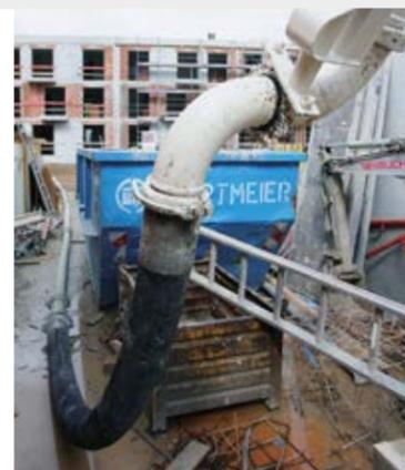
Bei Baustellen in „zweiter Reihe“ hat die 20-4 Sanima die Nase vorn: Über eine an der Mastspitze angeschlossene Verlängerungsleitung können weit entfernte Einbringstellen erreicht werden, die selbst ein Großmast der 60 m Klasse nicht bedienen könnte.
