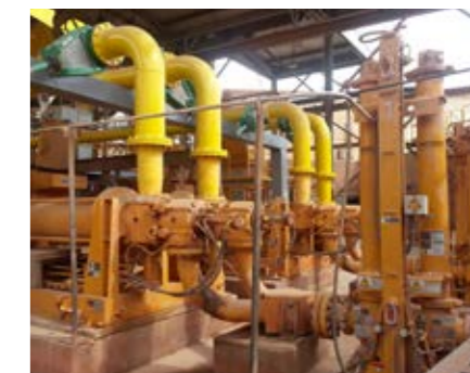
Система VPD устанавливается за поршневым насосом HSP для обработки шлама
