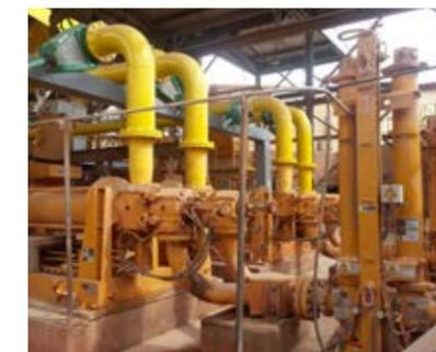
Sistema VPD instalado após uma bomba de pistão HSP para manuseio de rejeitos
