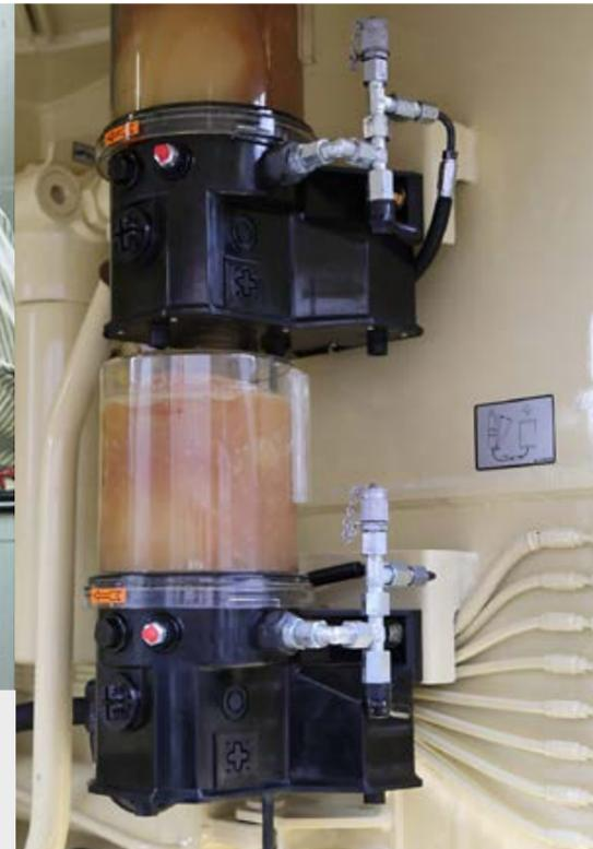
Graissage centralisé automatique : le graissage centralisé électrique pour la trémie est garant de l'optimisation de la durée de vie des composants fortement sollicités sans efforts supplémentaires.
