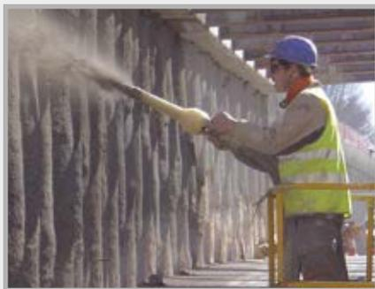
Les pompes à béton fin telles que la P 715 sont des plus polyvalentes. Elles se prêtent aussi bien à la projection qu'au pompage de béton fin avec une granulométrie de 16 mm au maximum.
