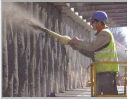
Las bombas de hormigón fino como la P 715 se caracterizan por ser unos de los sistemas más polivalentes. Pueden utilizarse para hormigón proyectado o para bombear hormigón fino de hasta 16 mm.
