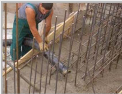
Les pompes à béton fin telles que la P 718 sont des plus polyvalentes. Elles se prêtent aussi bien à la projection qu'au pompage de béton fin avec une granulométrie de 32 mm au maximum.
