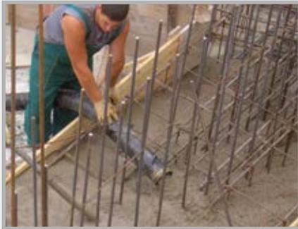
Feinbetonpumpen, wie die P 718, zählen zu den vielseitigsten Systemen. Sie können sie für Spritzbeton einsetzen oder für das Pumpen von Feinbeton bis 32 mm.
