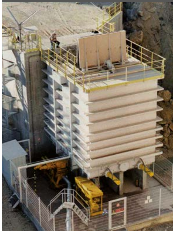
Le Teil Lafarge, France
