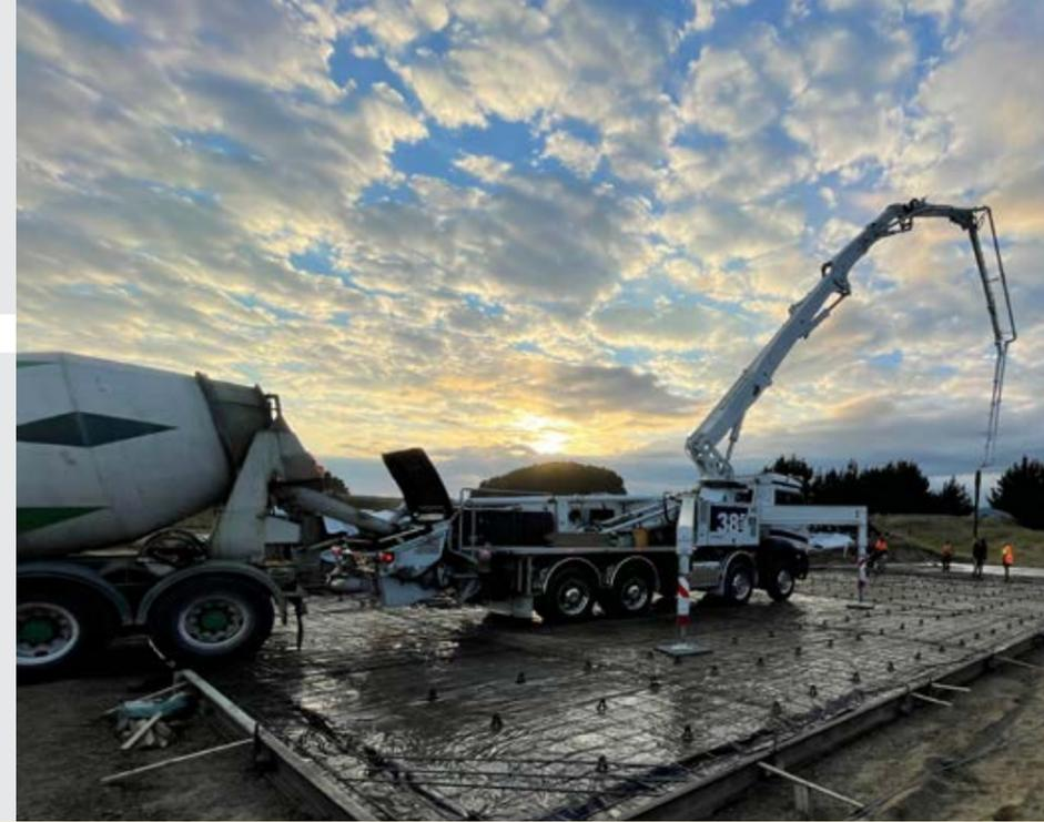
Una vez en la obra, esta clase despliega todo su potencial: plumas de distribución flexibles de 4 o 5 brazos que pueden trabajar con precisión a alturas de despliegado inferiores a 4 m incluso en pasillos, túneles o bajo puentes. Esto hace que el uso en obras pequeñas y medianas sea muy eficiente.
