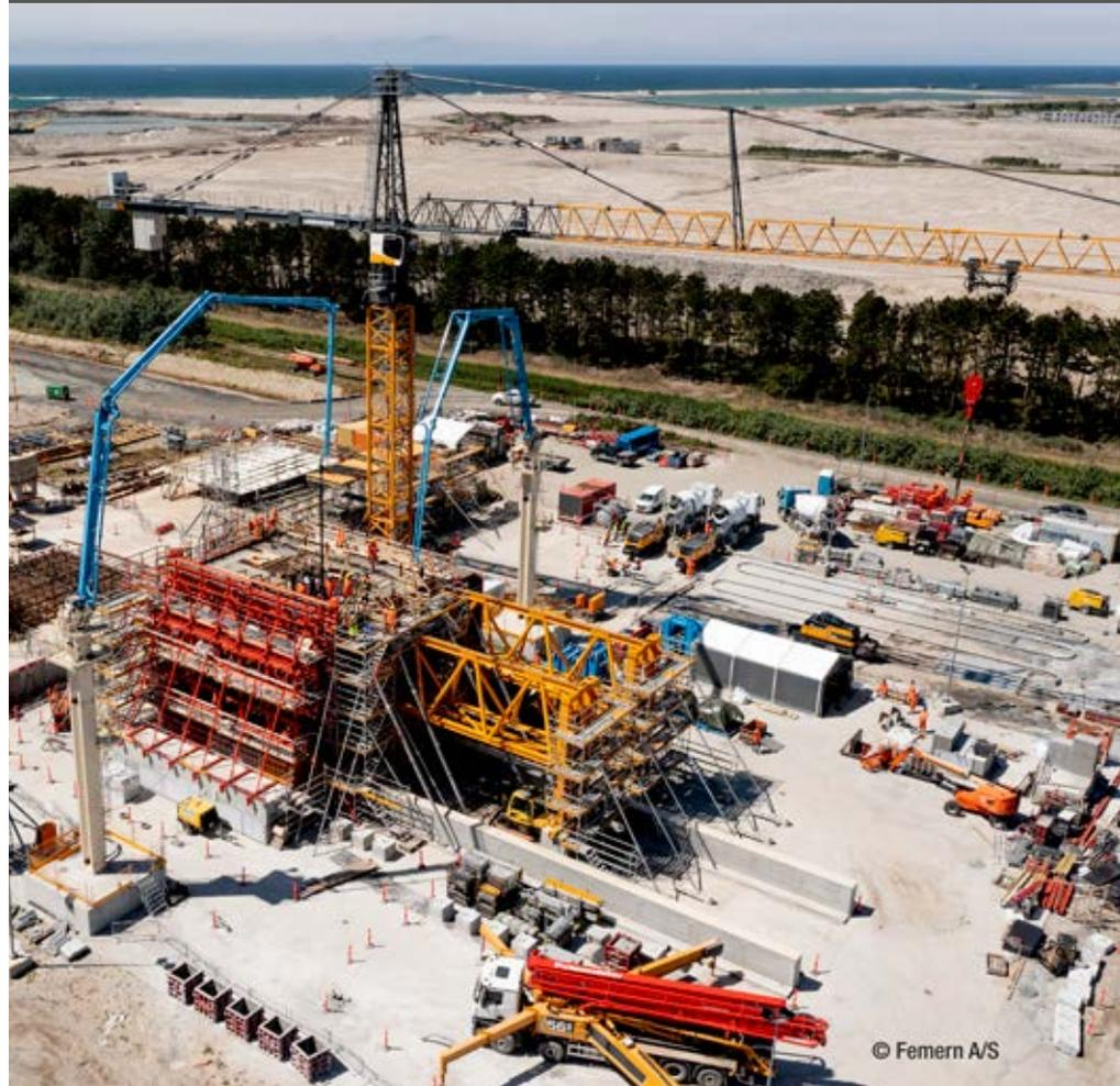
Betonage eines Tunnelsegments mit zwei stationären Betonpumpen BSA 2108 HP E und zwei Verteilermasten MXR 32-4
