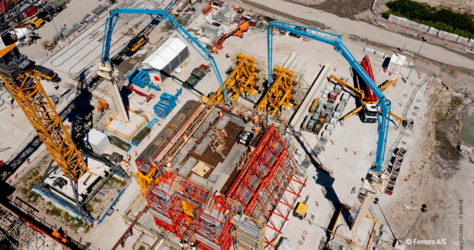
Betonage eines Tunnelsegments mit zwei stationären Betonpumpen BSA 2108 HP E und zwei Verteilermasten MXR 32-4
