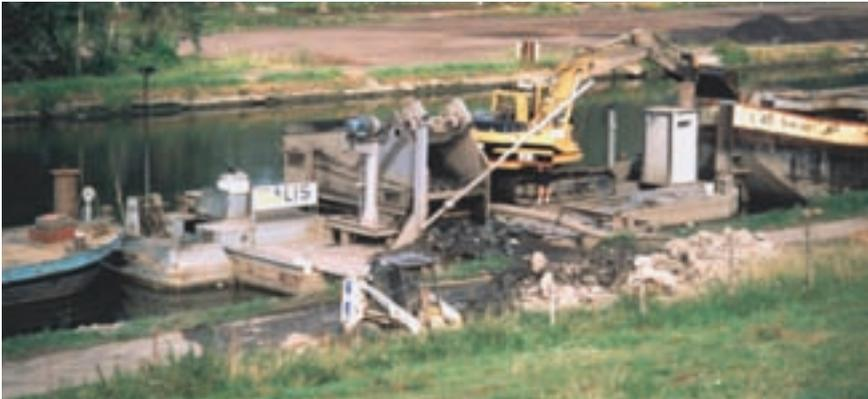
Schlammhandling-Anlage mit S-Rohr-Pumpe und dieselbetriebenem Hydraulikaggregat, montiert auf einem Ponton beim Einsatz in einem Kanal in Belgien
