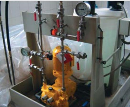
**Oben:** BLI Dosierstation mit Mischbehälter und Steuerung
