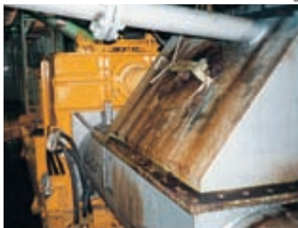
Materialzulauf zur Doppelwellen-Vorpresseinrichtung
