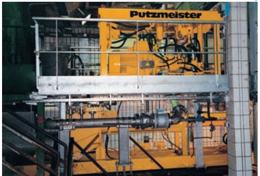
Steuerwarte und Aggregat sind oben, die Pumpe mit Vorpresseinrichtung ist unten installiert
