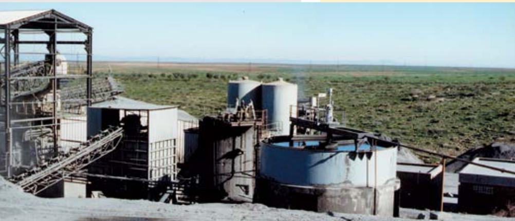
und Bergeschlämmen aus Eindickern vermischt und wieder nach unter Tage verbracht. Die Berge werden in unmittelbarer Nähe vom Schacht in einer Brechanlage zerkleinert, klassifiziert und von einem Förderband in einen Mischer übergeben. Der bei der Erz-Separation angefallene Bergeschlamm wird entwässert, in einem Silo aufgefangen und ebenfalls dem Zwangsmischer aufgegeben.
